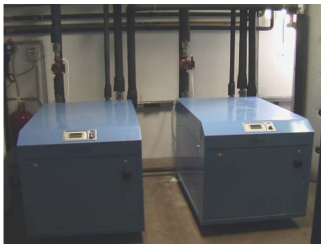
4. ábra. A Vastalanító épületről és a beépített hőszivattyúkról készült felvételek
