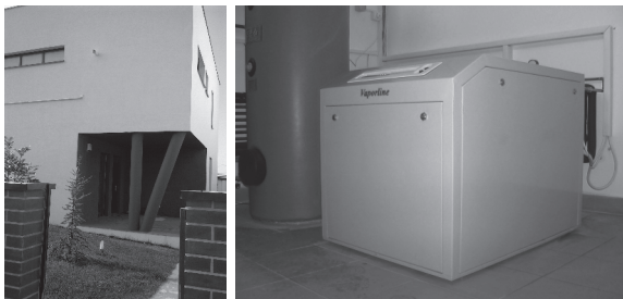
9. ábra. A Vaporline® GBI13-HACW sólé-víz (B/W) hőszivattyú bukaresti beépítéséről készült fotók: a 180 m 2 -es családi ház homlokzata és hőközpontja. A rendszerhez 3 db 100 m hosszú, U-hurkos földszonda csatlakozik. (Forrás: Geowatt Kft.)
