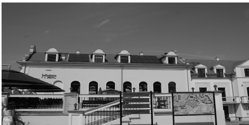
Fot. 3. Dom Pielgrzyma w Kodniu – instalacja solarna na dachu budynku. (fot. autor)
