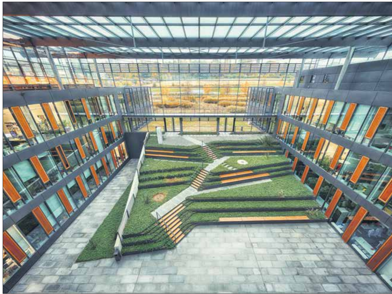
Große Glasflächen wie hier im Biologie-Bau ermöglichen lichtdurchflutete Gebäude, sind aber energetisch schwierig. Das Projekt »Camper-Move« erforscht hier beispielsweise, wie man den Bau sinnvoll vor zuviel Wärme schützen kann. Foto: Florian Bieler
