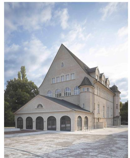
Alle Fenster (mit Ausnahme der noch originalen Doppelfenster an der Nordseite des Hörsaals) wurden durch neue Isolierglasholzfenster nach dem bauzeitlichen Muster ersetzt. Zwar
