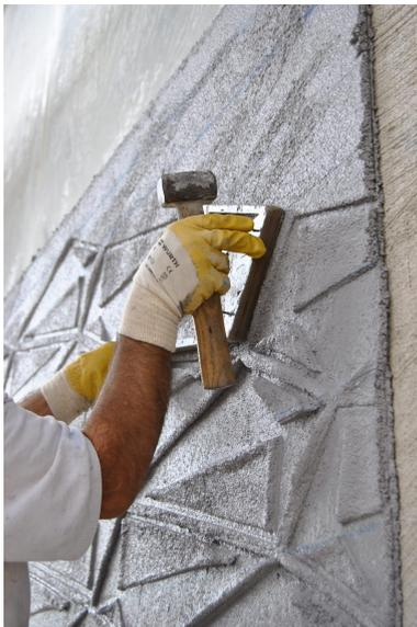
Bei der Gestaltung der Fassade fokussierten sich die Planer auf den Umgang mit den vertikalen Fassadenflächen sowie die Art der Verarbeitung. Waren zunächst noch vorgefertigte Putzplatten im Gespräch, fiel die Wahl schnell auf eine händische Bearbeitung der Putzflächen, um dem
