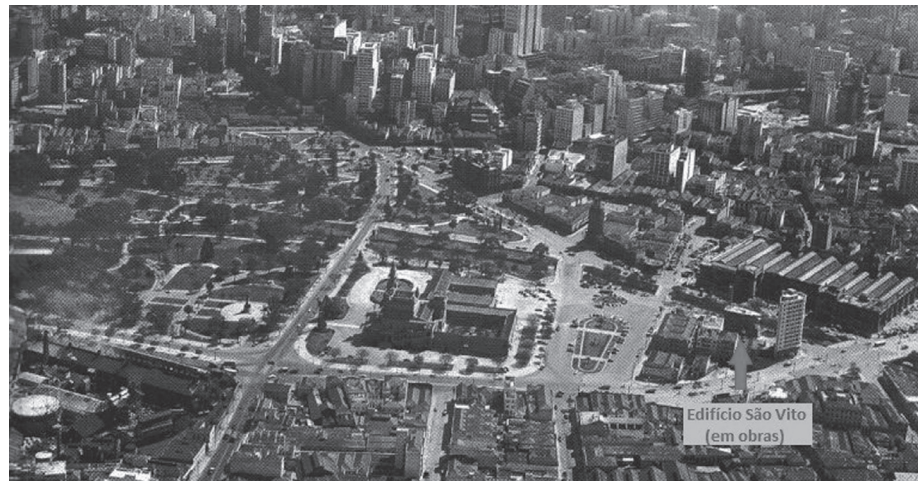
Figura 2: Vista aérea do Parque D. Pedro II em 1954 – Edifício São Vito em construção
