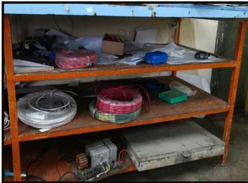
Figura 30: Parte inferior de la división 3 del área eléctrica
