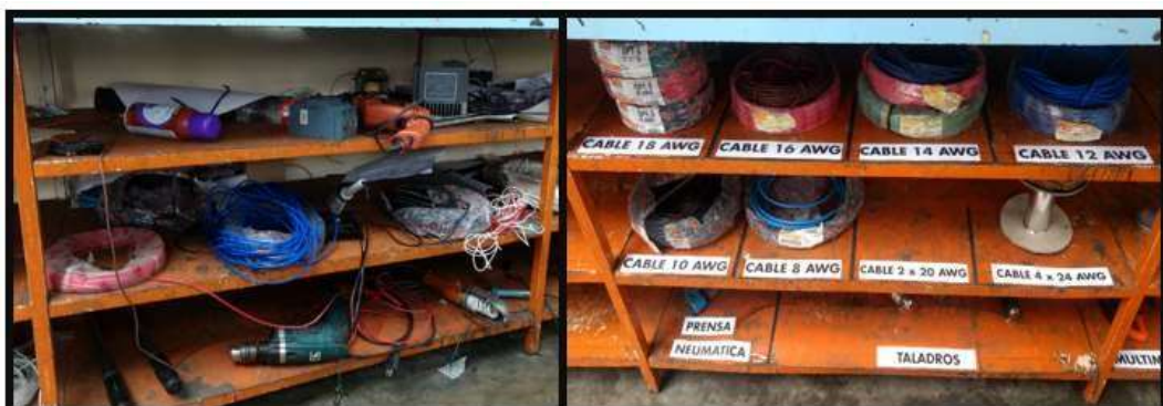
Figura 34: Seiton en la división 2, parte inferior (área eléctrica).
