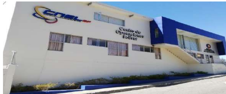
Figura 2-3. Edificación 1 Realizado por: Cherres, N.; Salán, J. 2019
