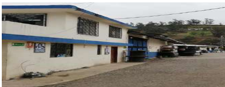
Figura 3-3. Edificación 2 Realizado por: Cherres, N.; Salán, J. 2019
