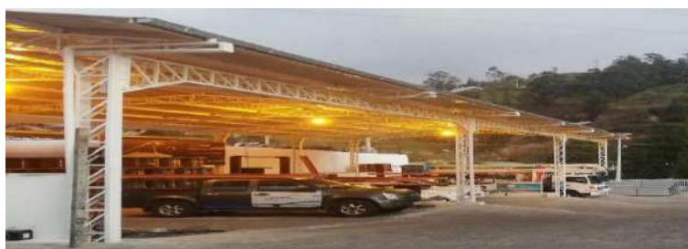
Figura 8-3. Edificación 7 Realizado por: Cheres, N.; Salán, J. 2019
