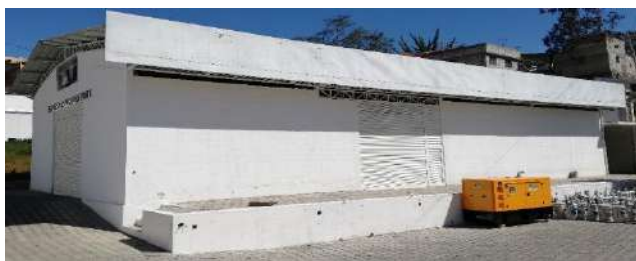
Figura 7-3. Edificación 6 Realizado por: Cheres, N.; Salán, J. 2019
