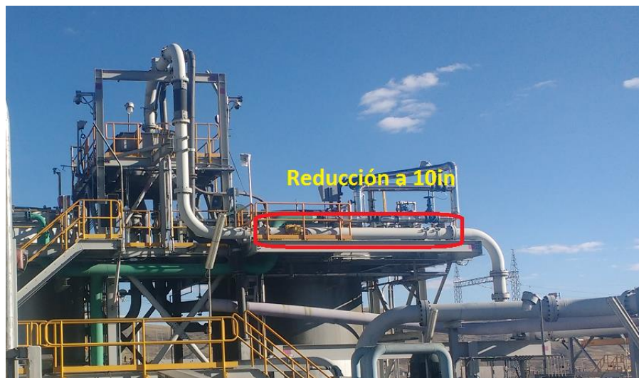
Figura 50. Ubicación de cambio de tubería de 12" a 10"
