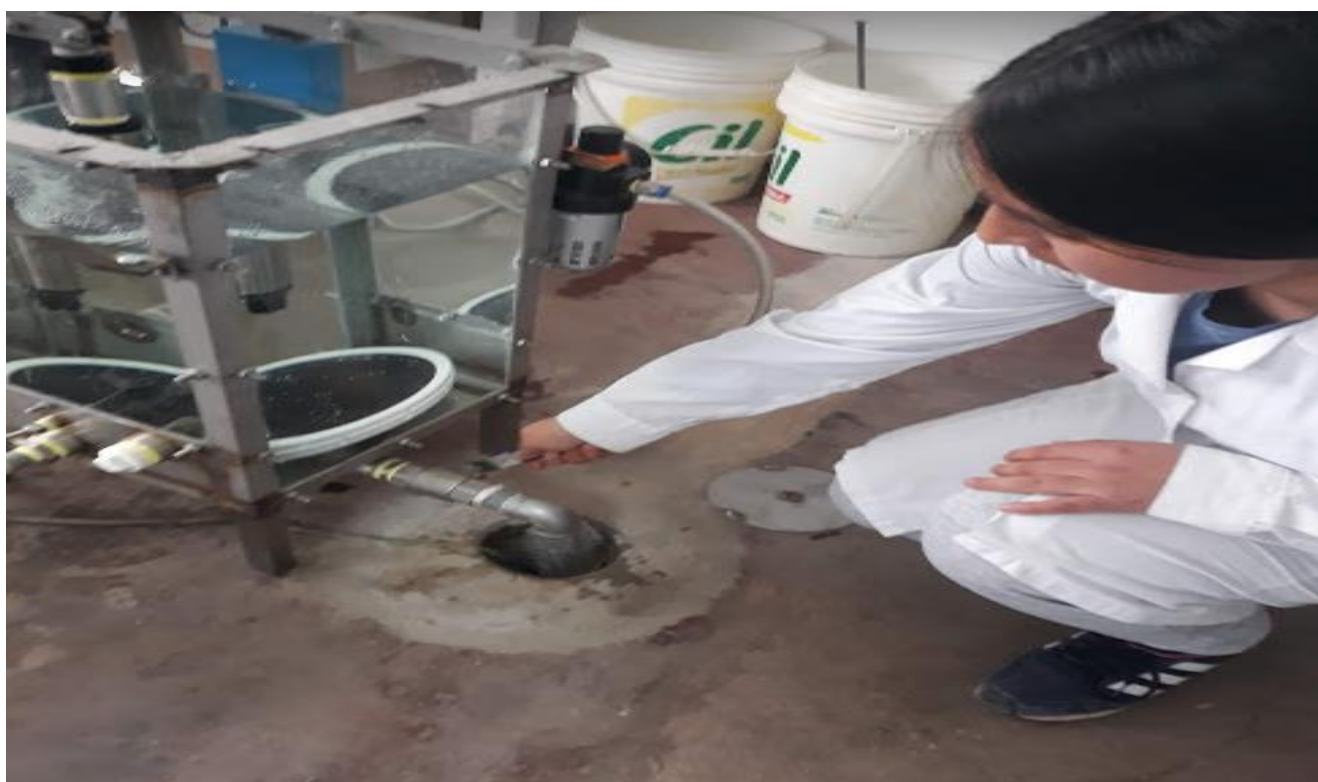
ANEXO 5. Descarga del tanque de aireación
