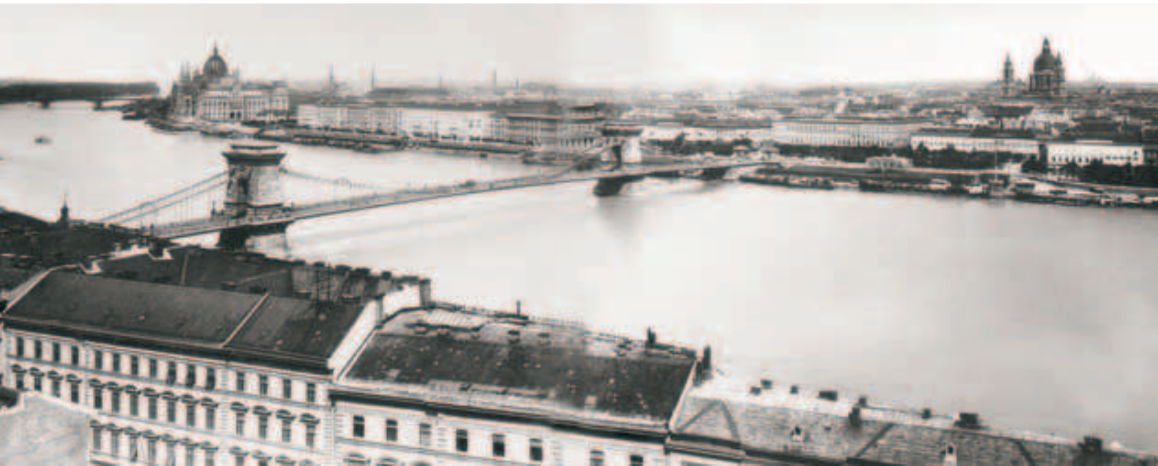
VI Ansicht des Pester Donaufufers mit Parlament, Akademiegebäude, Kettenbrücke und im Hintergrund der St.-Stephans-Basilika. Foto: György Klósz, um 1900
