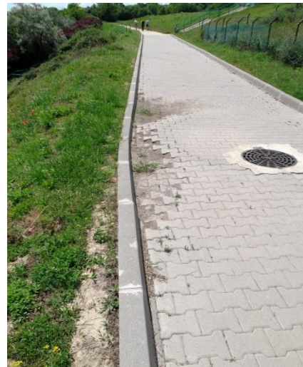
2-3.kép: Szuffóziós folyamatok miatt 2008-ban károsodott partvédelmi út a reambuláció előtt és után Dunaujvárosban (Balogh J. 2008, 2014)
