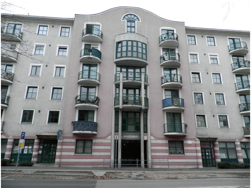
5. ábra A győri Nyugdíjsház homlokzata napjainkban
