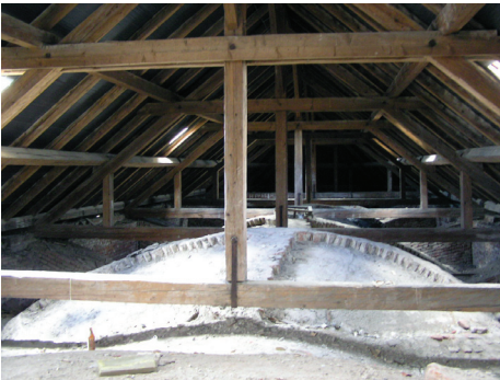
6. ábra Hossz- és kereszttengety mentén elhelyezett bordával erősített boltozat. Himod, római katolikus templom
