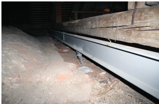
18. ábra Boltozat megerősítése az eredeti feszítőmű helyére kerülő acél feszítőművel. Vadosfa, római katolikus templom
