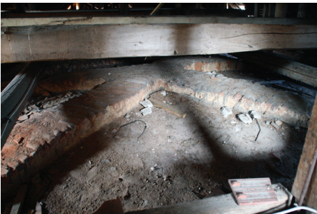
7. ábra Átlós bordákkal merevített cseh- boltozat. Kópháza, kegytemplom
