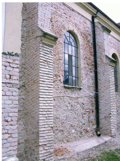
8. ábra Utólag támpillérekkel megtámasztott csehboltozatos templom. Újkér, római katolikus templom
