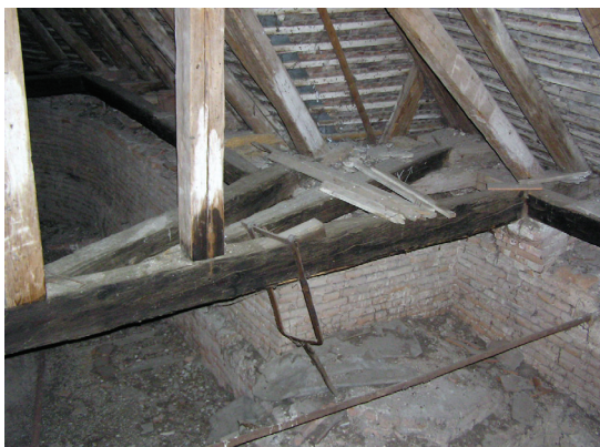
14. ábra A kötőgerenda felhasználása a boltozati feszítőtű szerepében. A szerkezet szemmel láthatóan nem alkalmas a boltozatok oldalnyomásának felvételére
