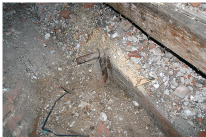
11. ábra Boltozati feszítőtű vízszintes gerendája és a ferde feszítőrúd csatlakozása. Vadosfa, római katolikus templom
