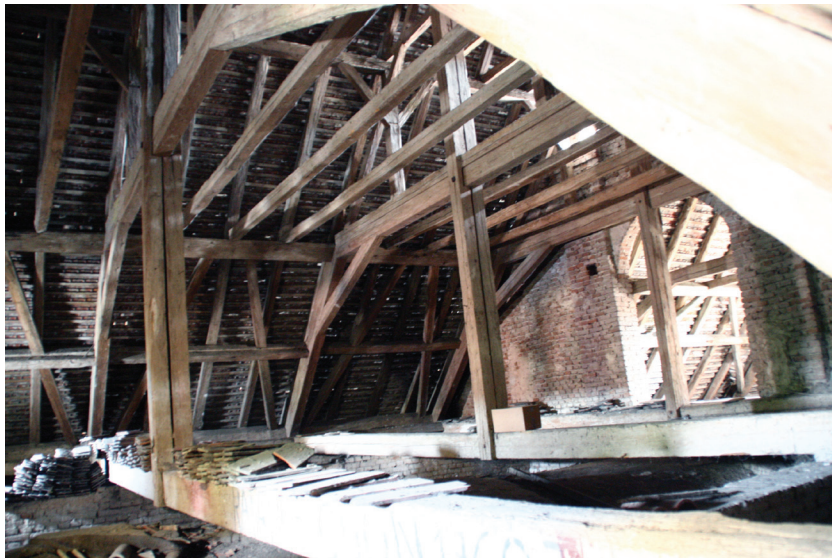
15. ábra Barokk fedélszerkezet. Fertőszentmiklós, római katolikus templom
