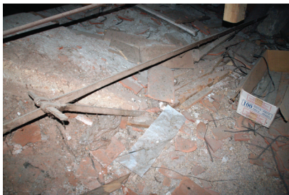
12. ábra Boltozati feszítőtű kovácsoltvas elemekből. Kópháza, kegytemplom
