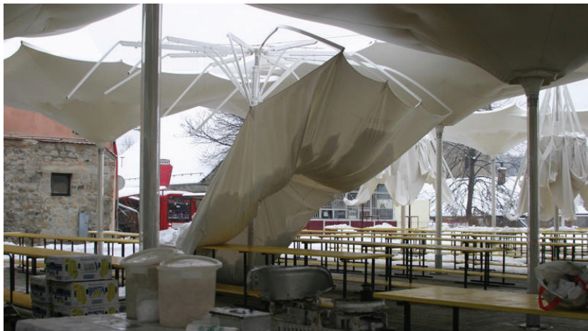
9. ábra Hóteher hatására tönkrement szerkezet
