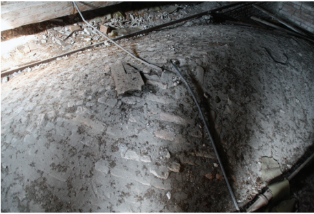
5. ábra Fecskefarkú falazással készült csehboltozat. Pinnye, római katolikus templom
