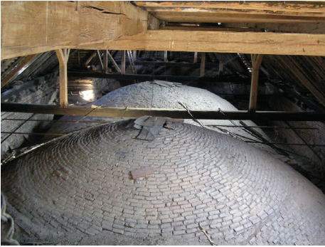
4. ábra Gyűrűsen falazott csehboltozat. Nagylós, római katolikus templom
