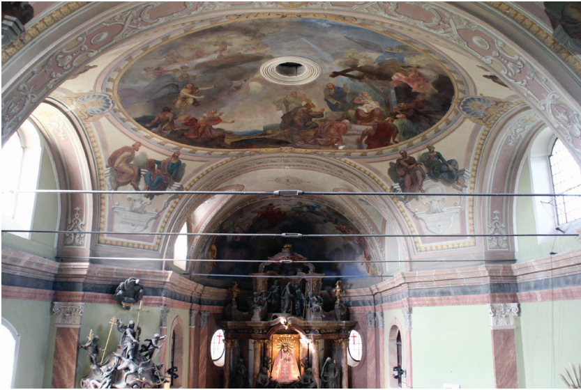
9. ábra Vonóvassal megerősített boltozat. Kópháza, kegytemplom
