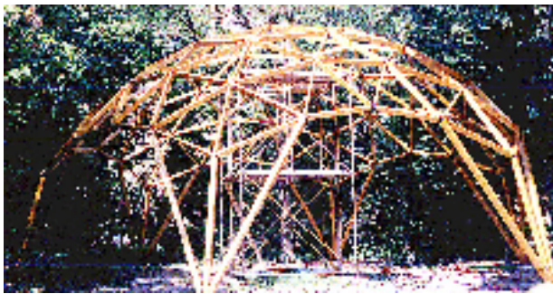
3. ábra – A háromszög rácsszerkezet burkolás előtt.
