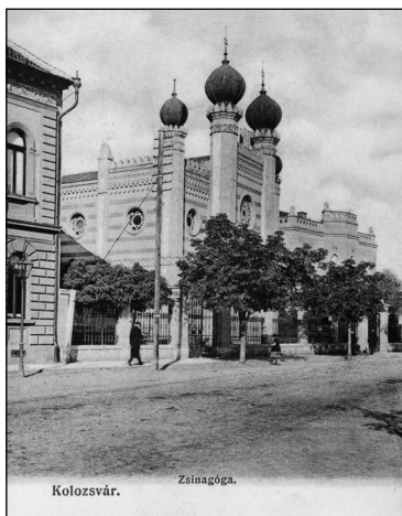
Imaginea 4. Sinagoga Neologă de pe strada Ferenc József, construită în 1887 (fotografie din anii 1890). 107
