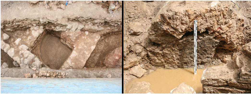
Fig. 2 Senhora. do Ó. 2A. Tanque de decantação coberto pelo pavimento em opus signinum do tanque ou natatio . 2B. Pormenor da cloaca (fotos cedidas por Carlos Batata)
