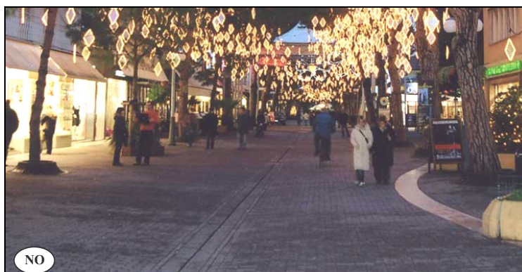
Fig. 6.46 – Fognolo di drenaggio posto erroneamente al centro di una strada ciclopedonale
