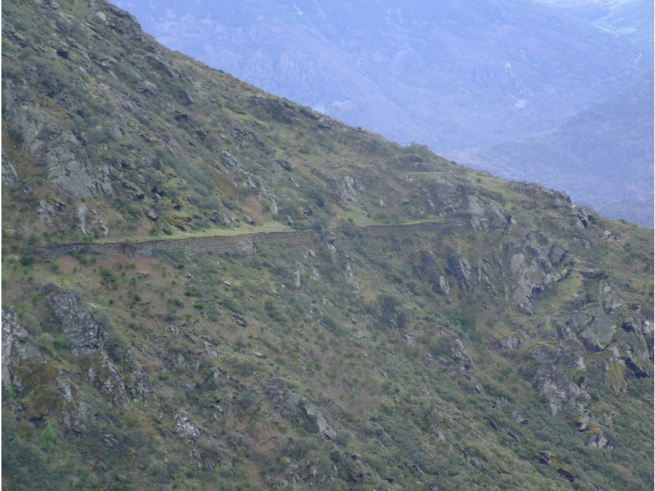
Figura n.º 14: Muros de sostenimiento del canal C-3 en las inmediaciones de la Ermita de la Virgen del Valle (Llamas de Cabrera). Foto: R. Matías.
