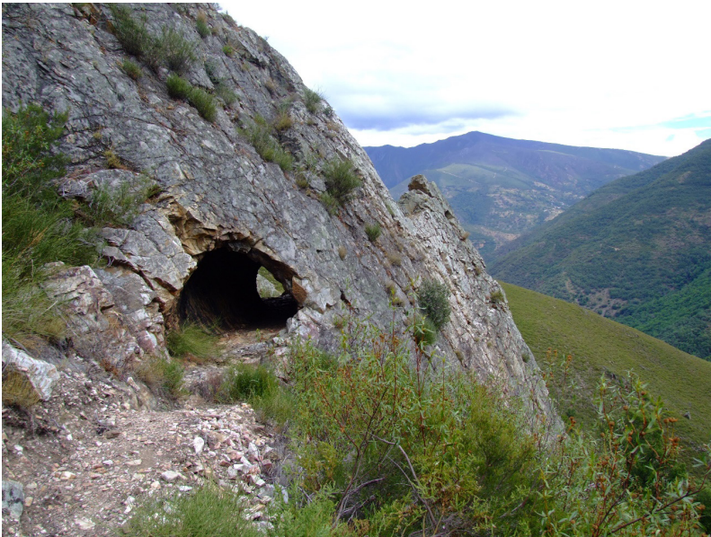
Figura n.º 6: Túnel del canal C-1 en las inmediaciones de Pombriego-Santalavilla. Foto: R. Matías.
