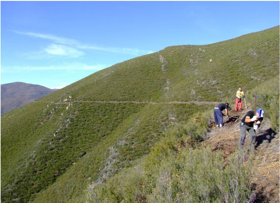
Figura n.º 12: Trabajos de recuperación del canal C-5 como ruta de senderismo en el valle Lleiroso de Llamas de Cabrera. Foto: R. Matías.
