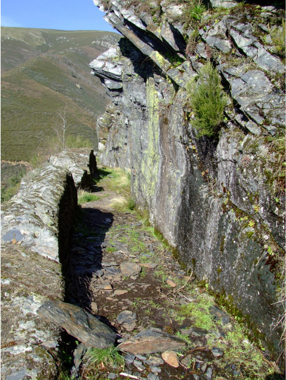
Figura n.º 5: Corte en la roca del Canal C-1 en Llamas de Cabrera. Foto: R. Matías.
