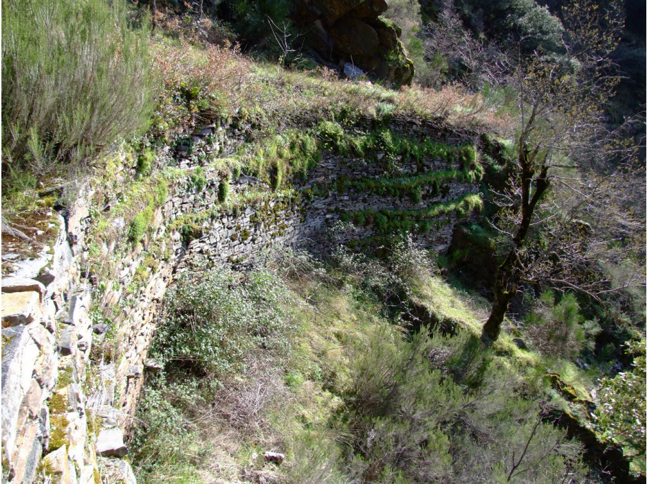
Figura n.º 8A: Muro de sostenimiento del canal C-1 en el Valle Lleiroso de Llamas de Cabrera. Foto: R. Matías.
