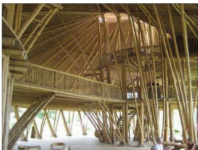
Gambar 3. Kontruksi bangunan Gedung Heart of School di Green School
