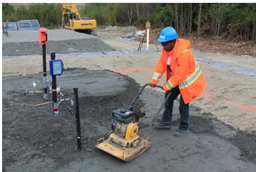
Figure 3-39 : Compaction du paste rock dans la cellule CR-4
