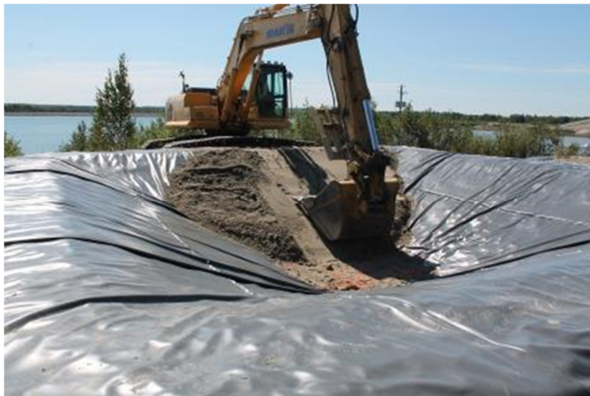
Figure 3-36 : Mise en place de la couche de sable de protection
