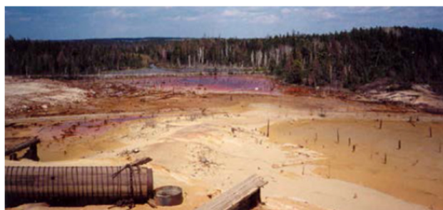
Figure 1-1 : Drainage minier acide, Site Manitou avant restauration (MERN)
