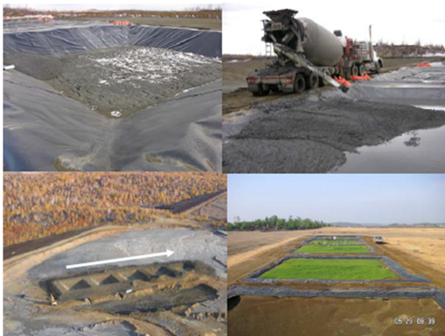
Figure 2-5 : Séquence de construction des lysimètres d'INCO (Wilson et al., 2010)
