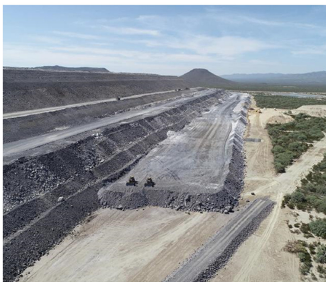
Figure 1-5 : Stériles miniers de la mine Penasquito (Newmont Goldcorp 2018)
