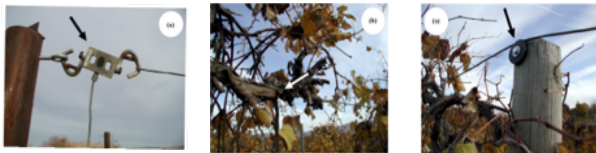
Figura 6 - Dispositivo nos arames (a) célula de carga alinhada com o arame junto ao poste final. (b) Crescimento do cordão envolvendo o arame. (c) Polia para apoiar o arame num poste intermédio. Fonte: Tarara, et al. (2009).
