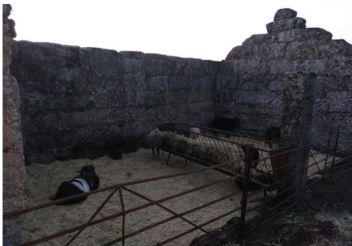
Figura 9: Edifício em ruínas utilizado para montagem de um HC. Início de montagem (fotografia original 2017)
