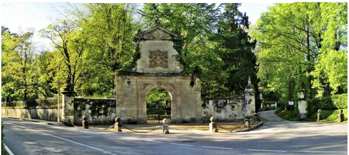
Ilustración 28: Portalón de entrada a la finca
