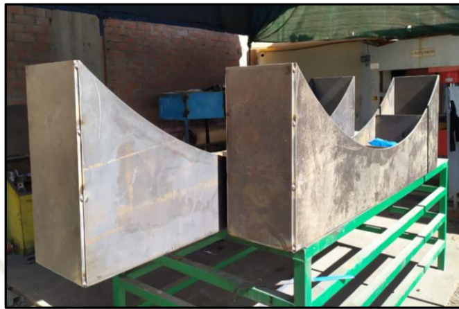
Figura 93 Armado de Soportes de Autoclave
