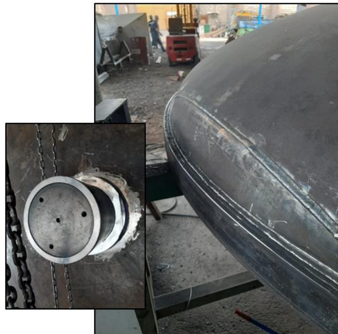
Figura 104 Armado de Anillo y Bocina de Compuerta. Fuente. Elaboración Propia
