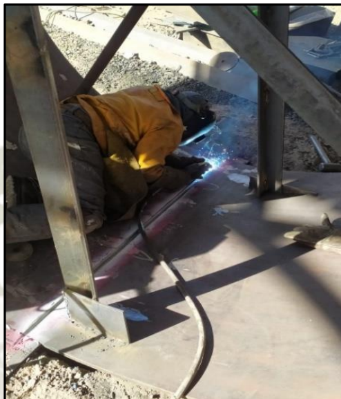
Figura 88 Atiesado y Soldadura de Virolas para el Cilindro Fuente: Elaboración Propia
