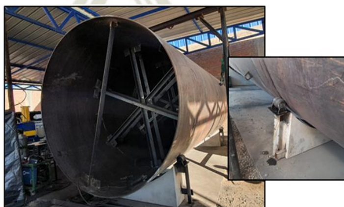
Figura 100 Armado de Cilindro Presurizado sobre Soportes
