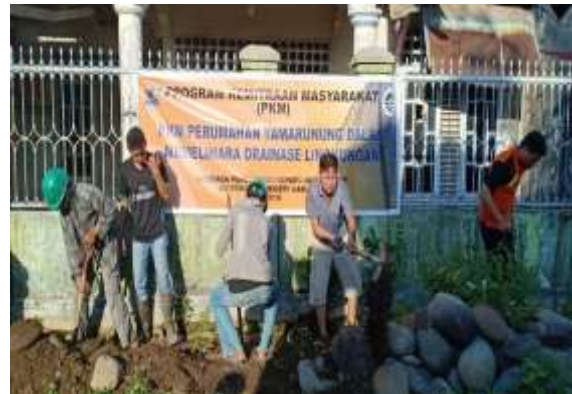
Gambar 6. Proses Pembuatan Saluran Drainase
