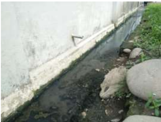
Gambar 4. kondisi drainase setelah diberi biopori yang sebelumnya airnya meluap hingga ke jalan raya
