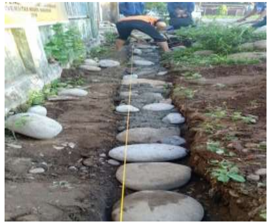
Gambar 5. Proses penggalian untuk pembuatan saluran drainase
