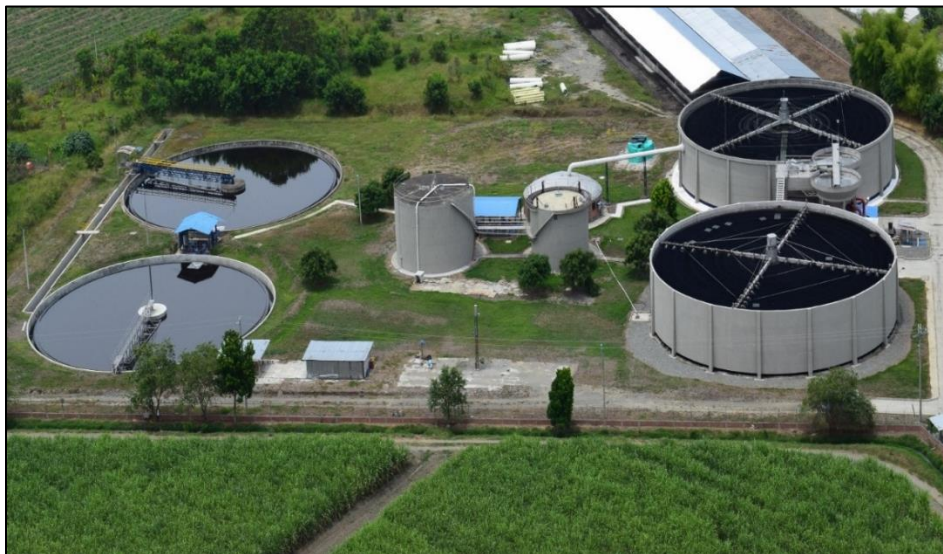
Unidades Construidas PTAR Tuluá
