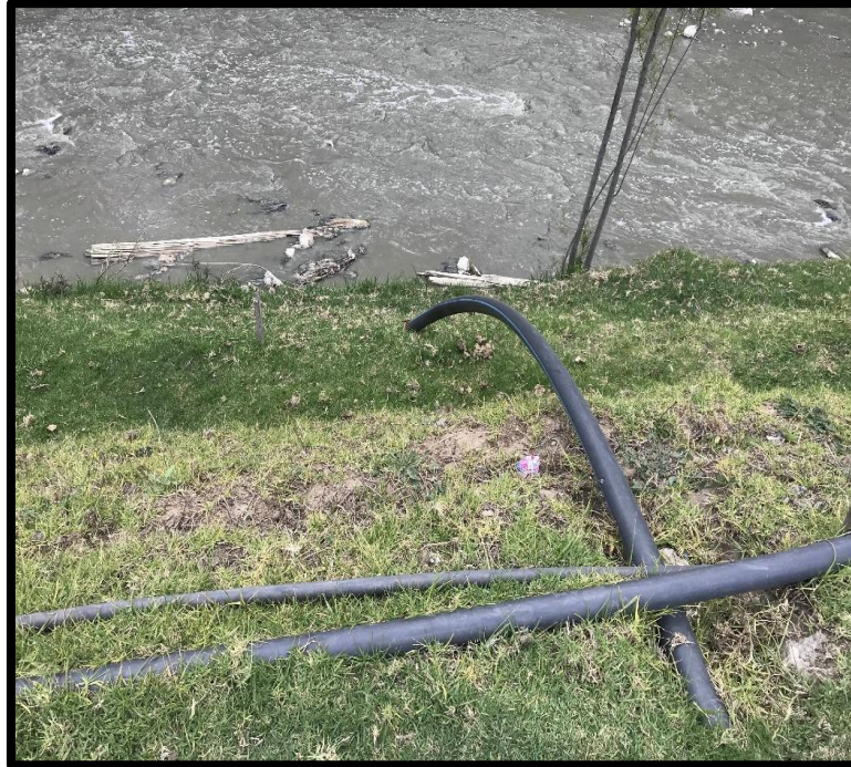
Figura 12. Fotografía captación. Fuente: El estudio 2020
