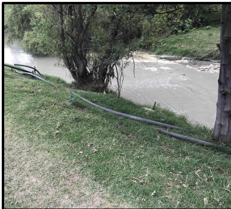
Figura 14. Fotografía captación. Fuente: El estudio 2020
