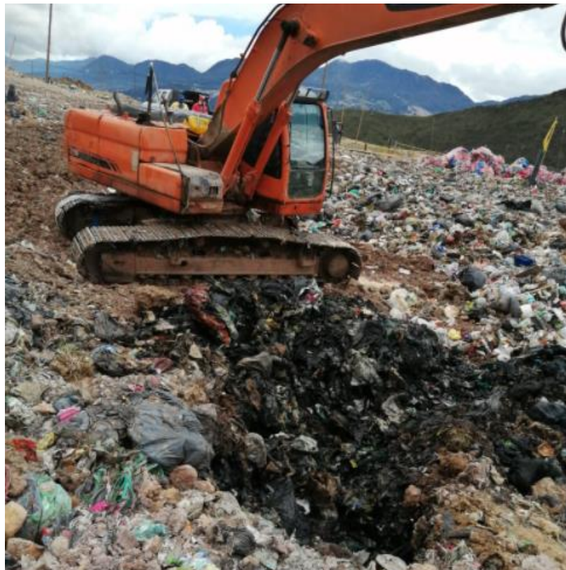
Figura 2-10 Extracción de residuos antiguos para el tanque No. 2
