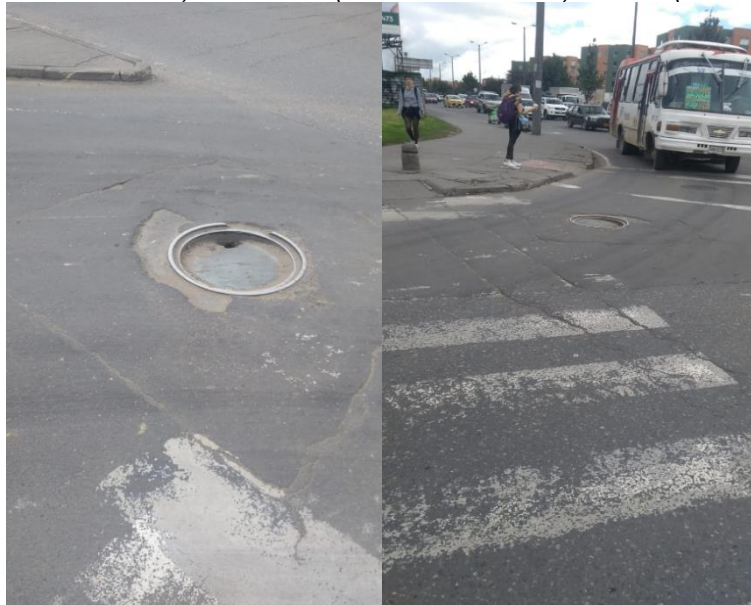
Figura 12 Acceso 7) Carrera 86 (Av. Ciudad de Cali) sentido (Sur-Norte).
