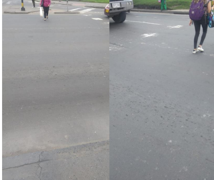
Figura 14 Acceso 2) Carrera 86 (Av. Ciudad de Cali) sentido (Sur-Norte)
