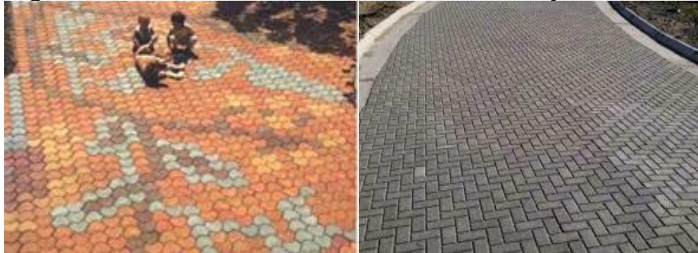
Figura 82 Pavimento articulado en zona recreativa y vía terciaria
