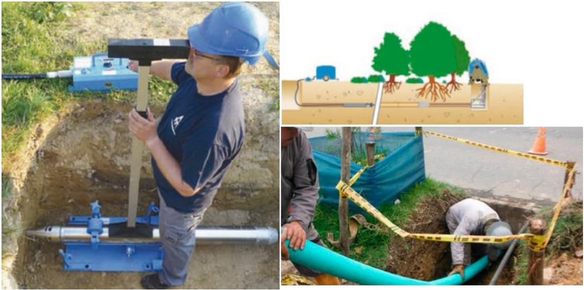
Imagen 16 Puesta de tubería
