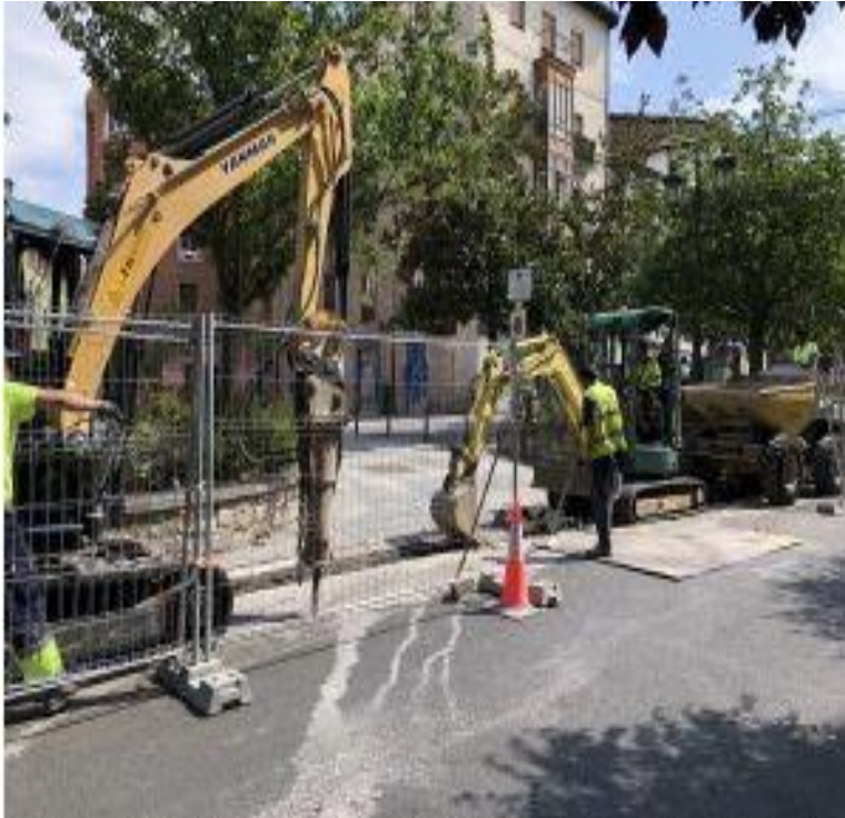
Imagen 8 Corte de pavimento
