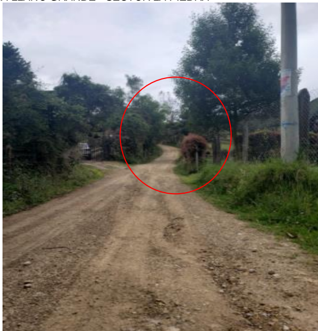
Ilustración 49 Curva de la VIA LLANO GRANDE - SECTOR LA PIEDRA
