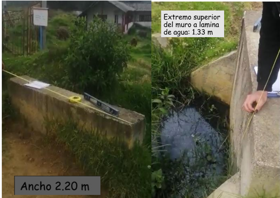
Ilustración 30 Muro de contención 1
