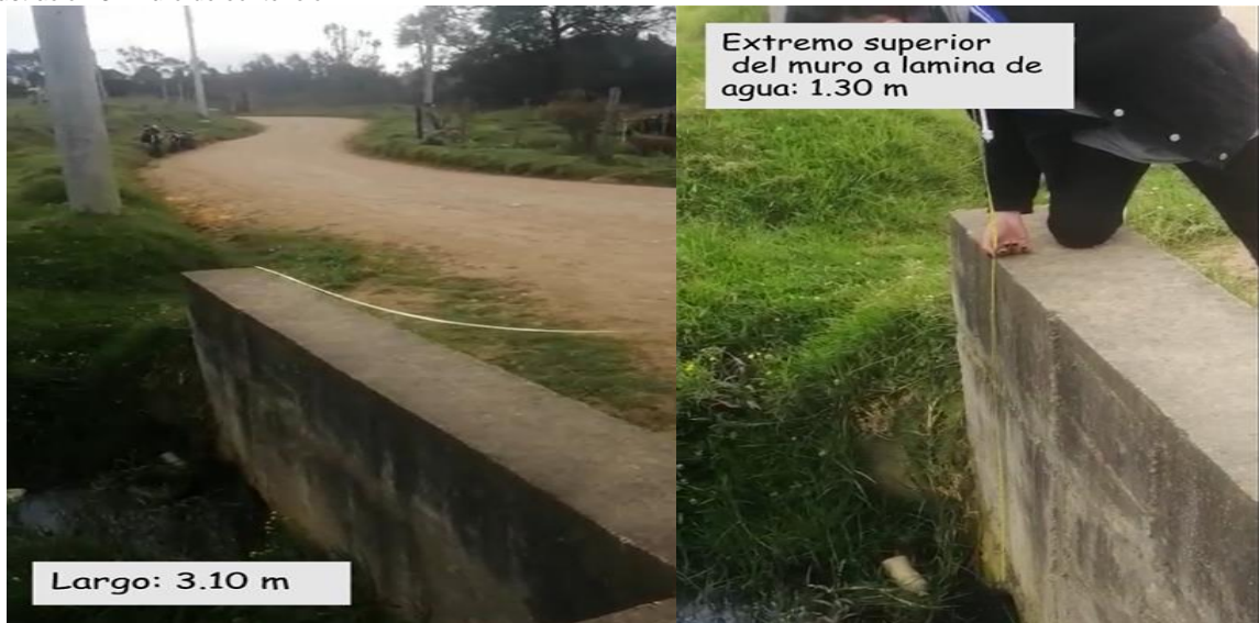
Ilustración 31 Muro de contención 2
