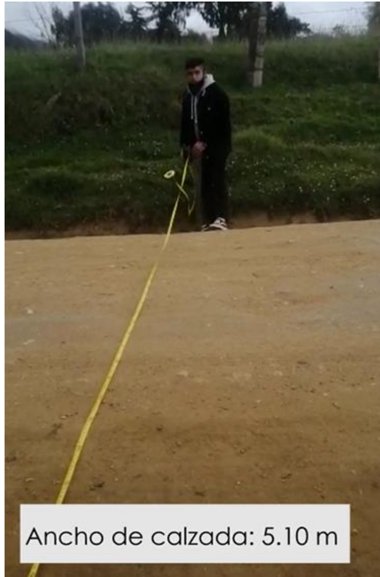
Ilustración 25 Ancho de la calzada.
