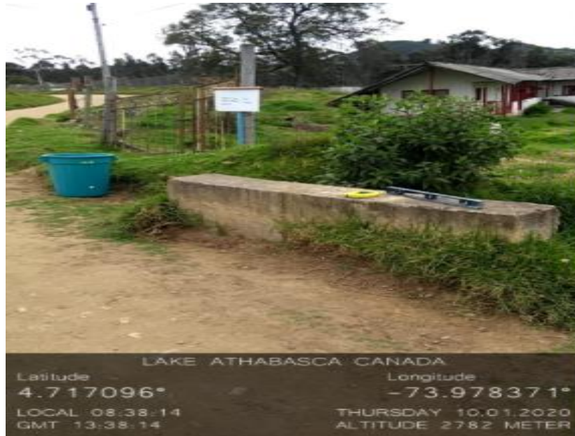
Ilustración 33 Coordenadas del muro de contención 1
