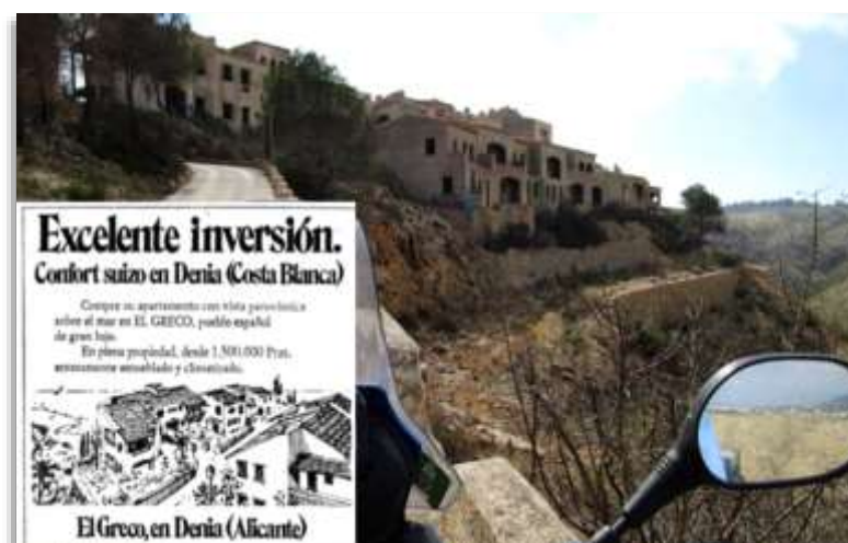
Fotografía 19: Ruinas de la urbanización “El Greco” en la Lloma del Castanyar. Superpuesto, el anuncio con que se publicitaba la urbanización en prensa. Fuente: https://www.lasprovincias.es/valencia/20080410/marina/demolicion-urbanizacion-greco-montgo-20080410.html
