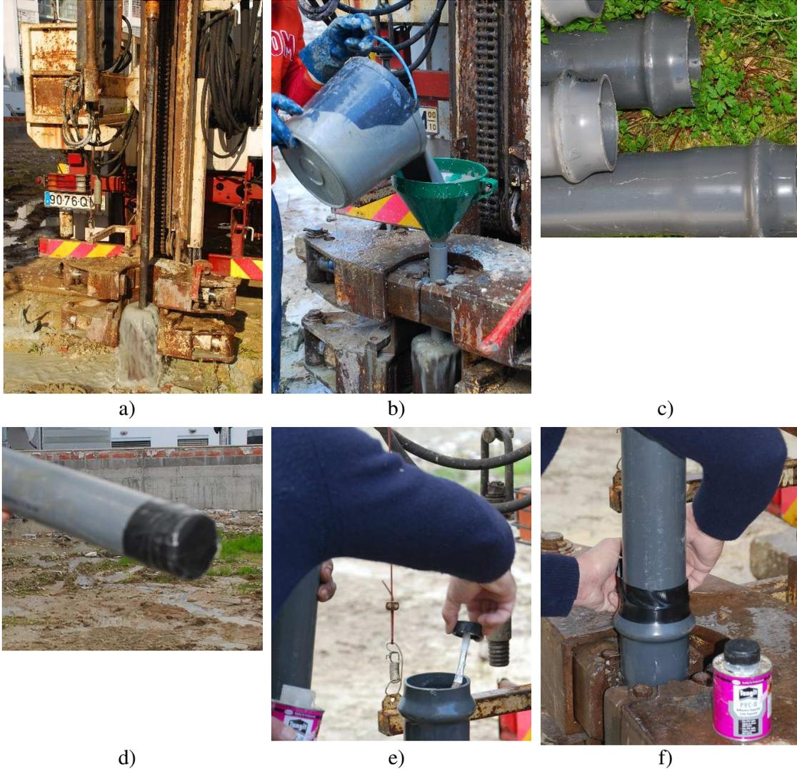
Figura 5. Montagem dos tubos de PVC para ensaios sísmicos no campo experimental: a) aspeto geral da furação; b) colocação da calda de cimento; c) tubos com ligações UNI; d) base do tubo obturada; e) colocação de cola nas uniões entre trechos; f) proteção das uniões com fita adesiva de alta resistência.
