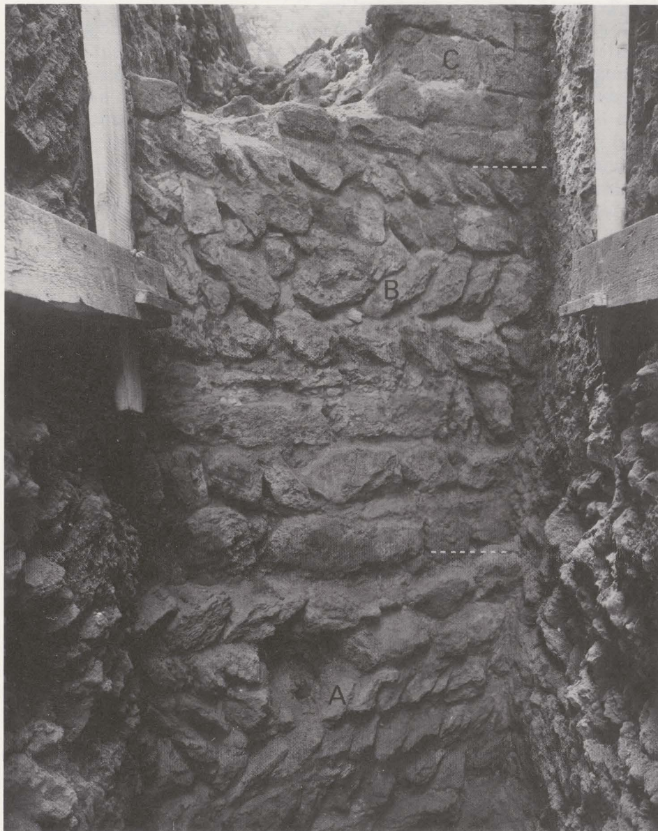
Fig. 7. Buitenwand van noordelijke donjonmuur
