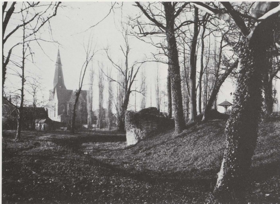
3 Zicht op het Prinsenhof naar het Westen: op de voorgrond, de mottheuvel met de gracht en het restant van de zuidwestelijke, bakstenen hoektoren; op de achtergrond, de gothische Ste-Gertrudiskerk.
