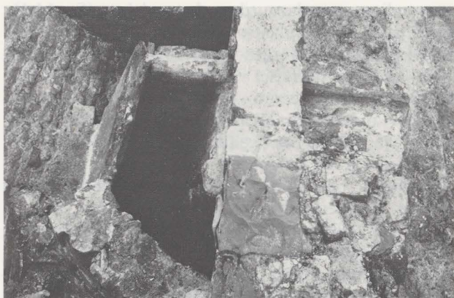
12 Latrine: oostelijke afvoergeul.
