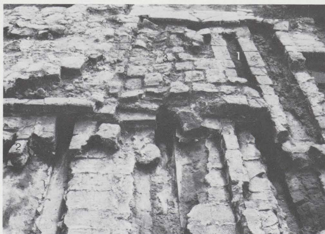
16 Detailopname van de vloeropbouw.
