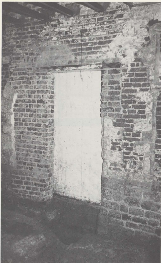
6 Restanten van de ingangspoort met rondboog in de zuidgevel van het molenhuis (Faze III-IV); rechts deel van het venster van de zuidgevel (Faze III-V).
