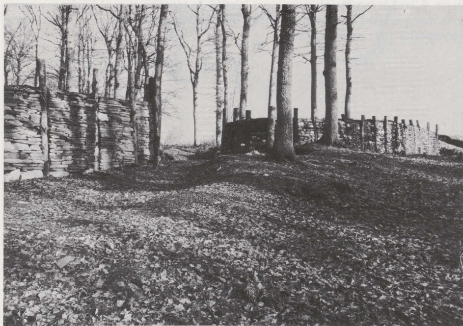
Fig. 47. Le rempart méridional restauré.
