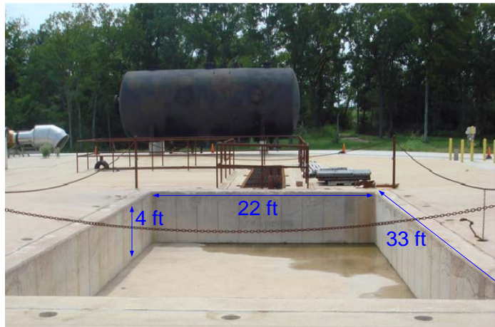
Figure 24. The 65 m 2 LNG Pit
