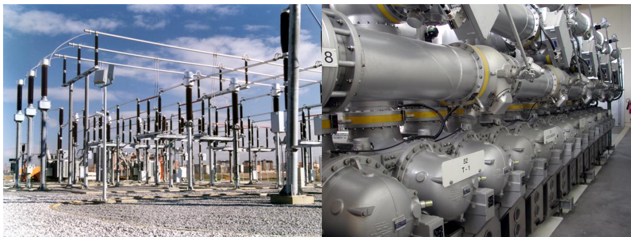
Figura 3-11.: Subestaciones eléctricas: aislamiento aire y SF 6 .
