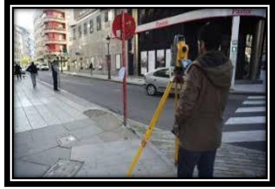
Imagen No 9 – Referencia de elementos mediante el uso de cinta métrica a la izquierda y estación total a la derecha Fuente: http://civilgeeks.com .
