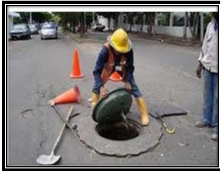
Imagen No 19 - Descripción de la imagen: Levantamiento de información de elementos de la red de alcantarillado sanitario - (Pozo de inspección) FUENTE ALCALDIA DE IBAGUE. Empresa Ibaguereña de acueducto y alcantarillado, 2018
