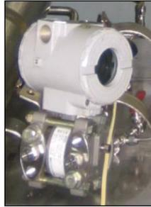
**Figura 4-7** Transductor de presión diferencial.
