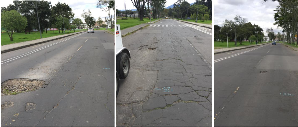
Figura 4-2: Registro fotográfico tramo TRM.
