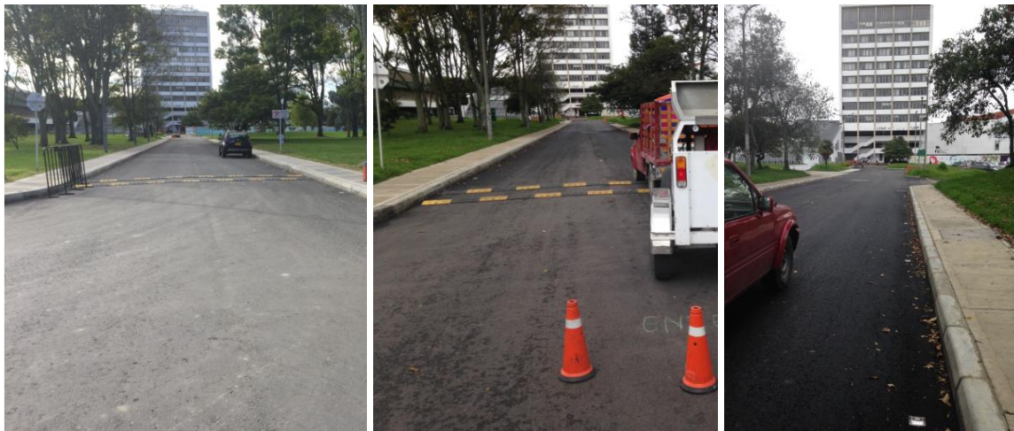
Figura 4-3: Registro fotográfico tramo TRB.
