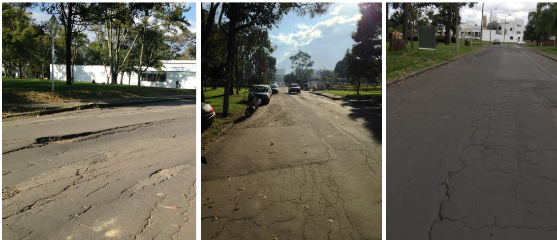
Figura 4-1: Registro fotográfico tramo TRA.
