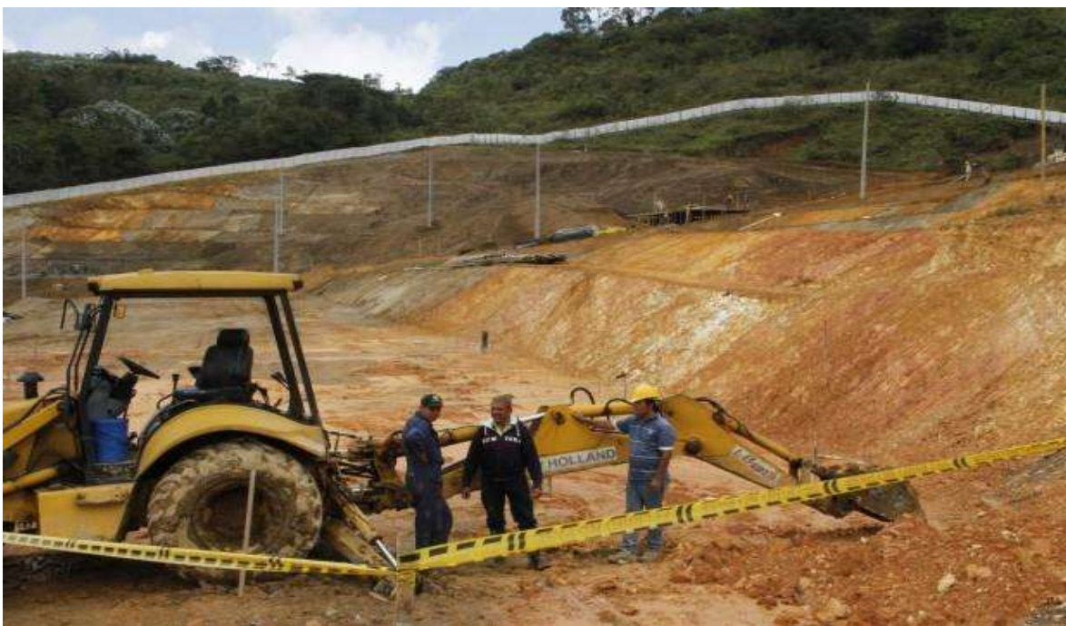
Ilustración 10. Obras de movimiento de tierras en las fases II y III. Fuente: Diario La Patria (2013).
