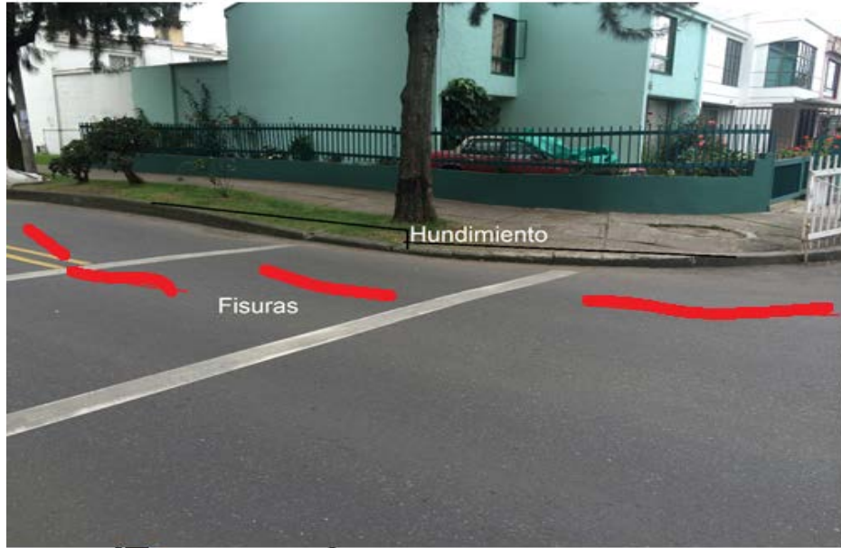
Figura 3-10. Hundimientos asociados a succión.
