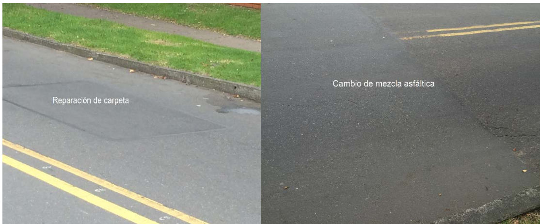
Figura 3-5. Reparaciones realizadas en el tramo B2 desde la toma de mediciones.
