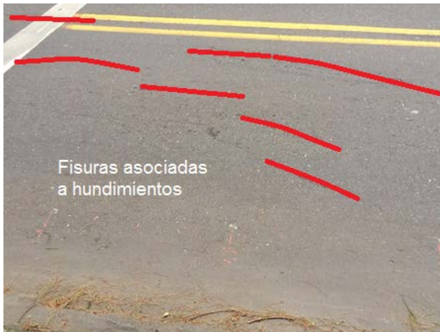
Figura 3-10. Hundimientos asociados a succión.
