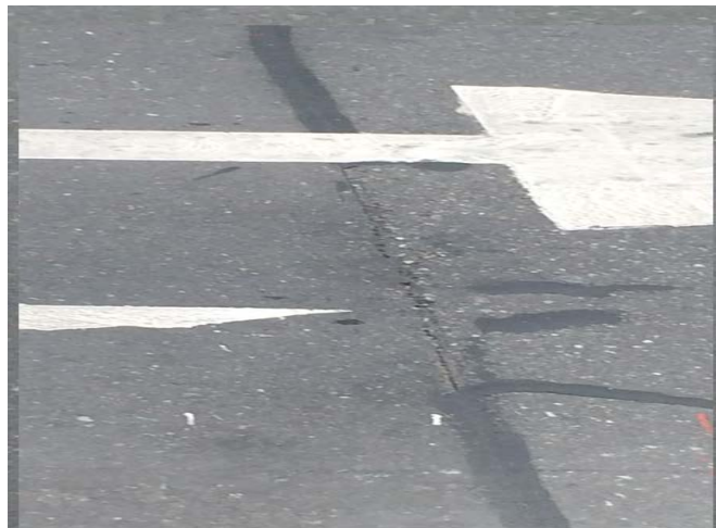
Figura 3-6. Sellado de juntas alrededor de las reparaciones del tramo B2.
