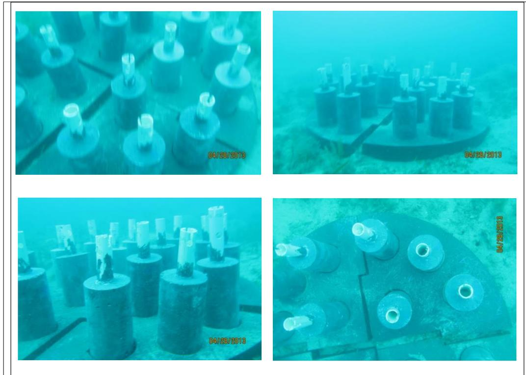
**Figura 36.** Instalación de módulo de arrecife artificial en el sitio 1, día 1. Fuente propia
