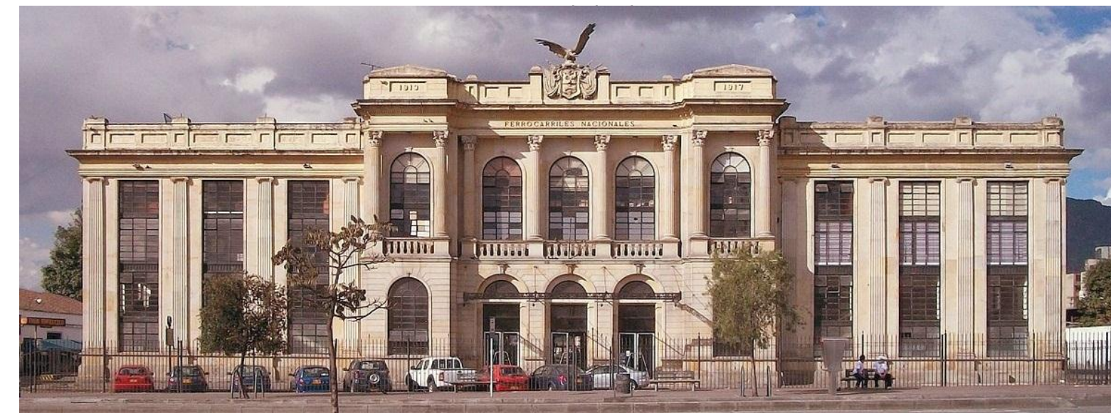
Fig. 01 Estación de la sabana fachada frontal.
