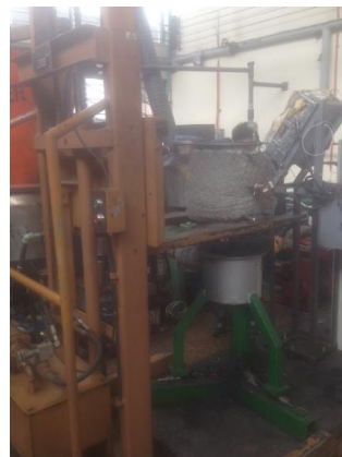
Figura 2. Desmontaje de módulos.
