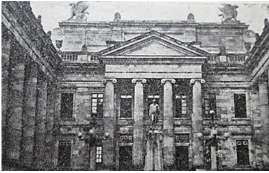
Ilustración 95. Capitolio Nacional. Costado Sur 130
